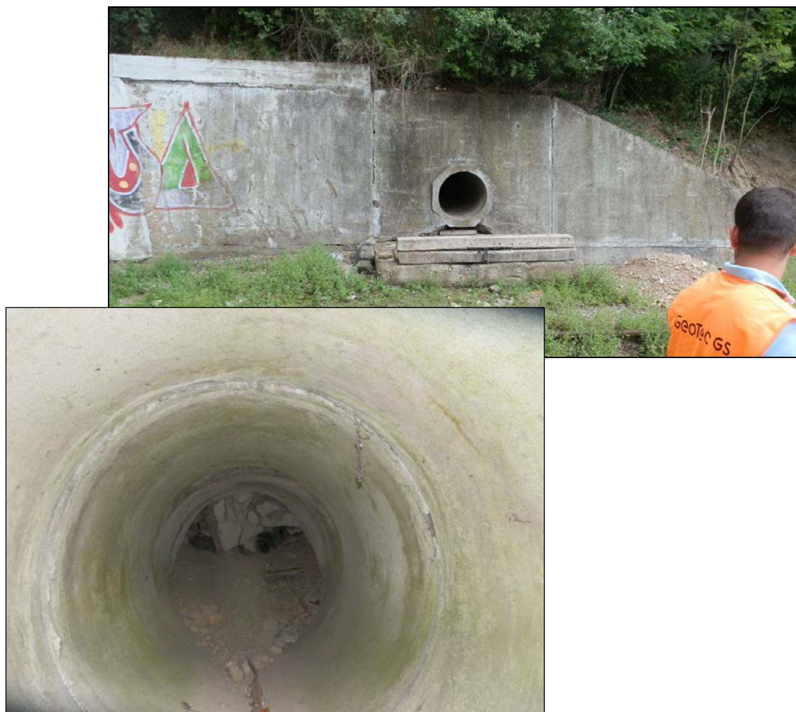
Obr. č. 2 - pohled na původní výtok z opěrné zdi, který je dnes zasypaný (detailní pohled do roury) a nefunkční. V roce 2003 zde vytékaly komunální splašky, výtok byl pravděpodobně součástí kanalizační sítě
