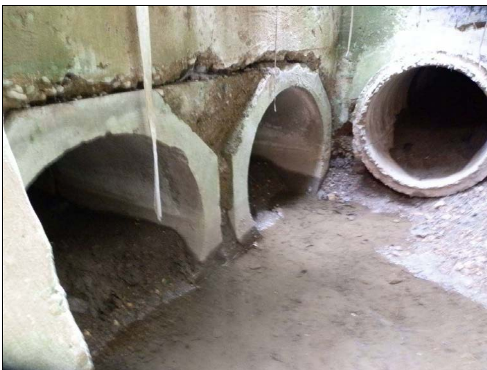
Obr. č. 4 - vnitřek jímky č. 1. Dvojice rour světlosti 750 mm je těleso propustku směřující pod koleji k šachtě č. 2. V čele je pravděpodobně výtok z drenáží z opěry Praha. Jímka byla vyčištěná v minulosti od usazenin.
