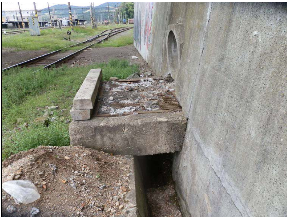
Obr. č. 3 - pohled na výtok z opěrné zdi a na šachtu č. 1. Ve směru od Plzně je do jímky zaústěn opevněný příkop, který je součástí drenáží v kolejišti.
