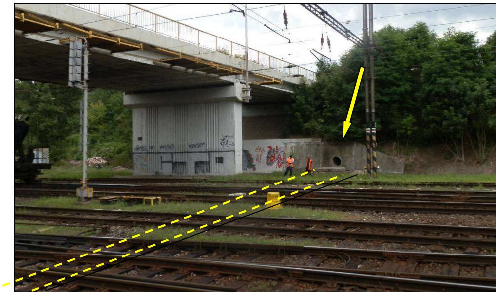
Obr. č. 1 - pohled na objekt skrytý pod kolejištěm. Původní výtok z opěrné zdi do propustku je označen šípkou, průběh propustku je žlutě
