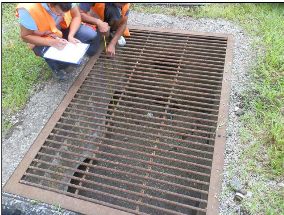
Obr. č. 5 - šachta č. 2 krytá mříží. Vlevo je dvojice rour světlosti 750 mm vedoucích k šachtě č. 1
