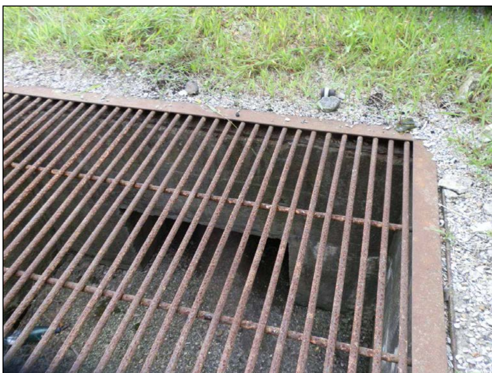
Obr. č. 6 - pohled na pravou stranu šachty č. 2, zde má propustek obdélníkový průřez a nosná konstrukce je desková.
